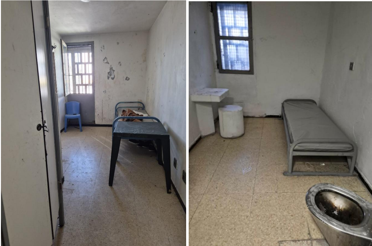
Cellules du quartier d'isolement
